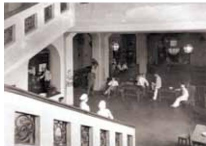
Treppenhaus Berliner Tor
