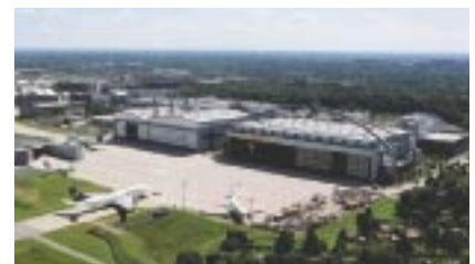
Firmengelände LHT in Hamburg-Fühlsbüttel (Foto: Manfred Schulze-Alex)
