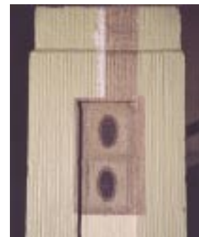
Treppenhalle: Freilegung der Verzierungen am Treppenantrittspfosten
