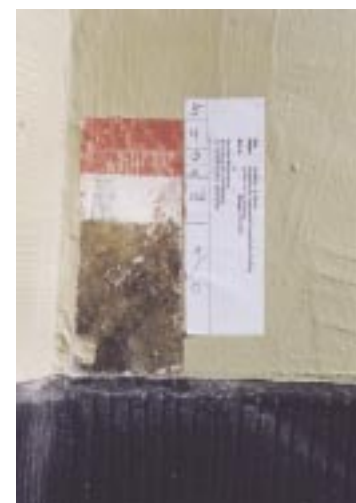
Windfang: Farbschichtfolge am Sockel
